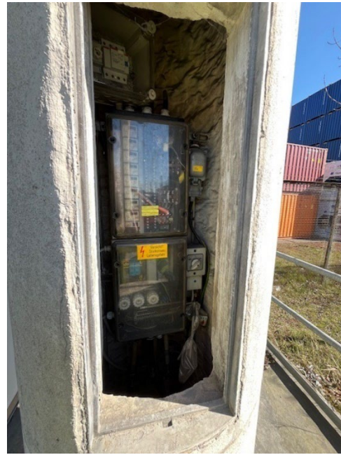
Abb. 8: Verteilung im Beton-LHM; Quelle: Foto HHVA
